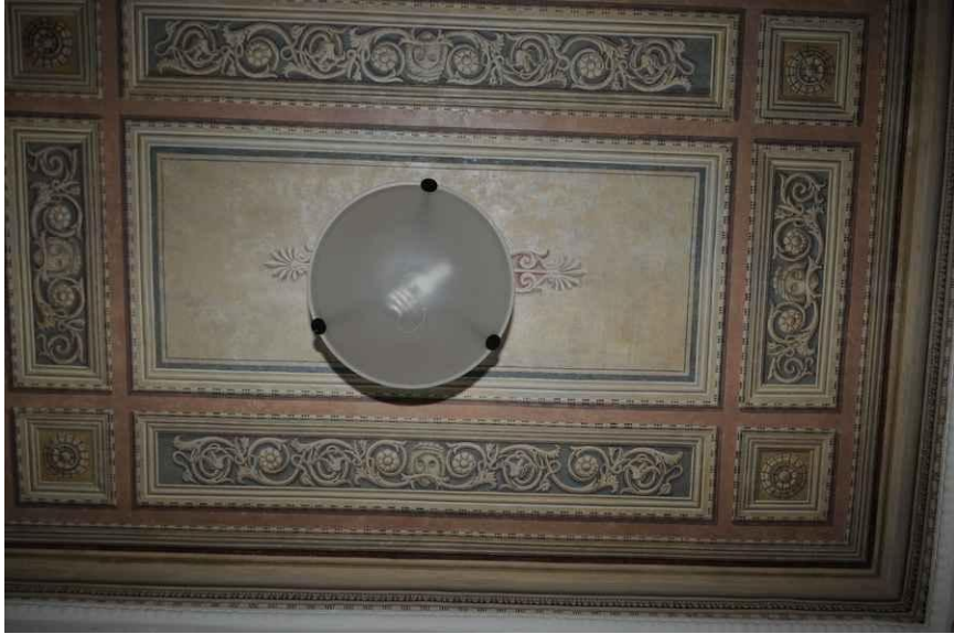
Αποκαλυφθείσα το 2010 οροφή εισόδου του κτιρίου..
